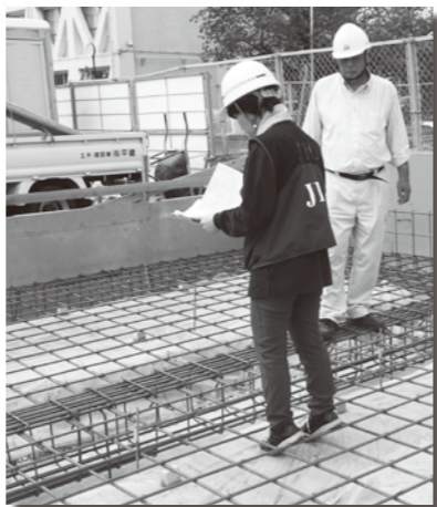
【J10 配筋検査】
