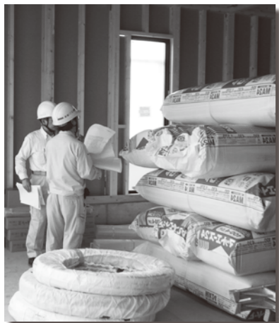
【役所中間検査】
